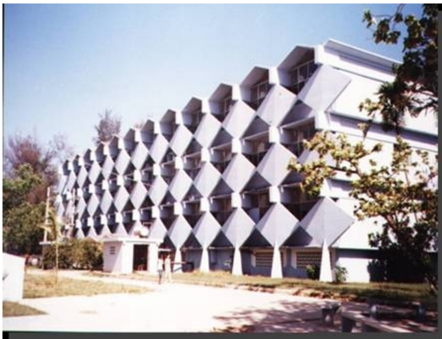
Foto 2. Uso del pre-fabricado en el edificio de la Universidad de Villanueva, hoy dedicado a la especialidad de técnicos medios en química
