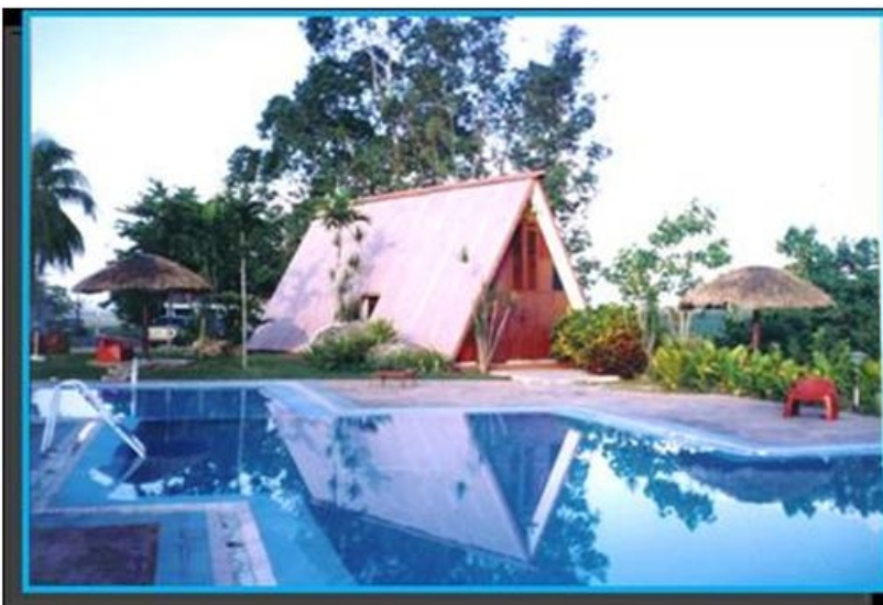
Foto 20. Cabaña del Sistema LH VT con impermeabilización de terrazo integral, en el entronque de San Diego, en Pinar del Río
