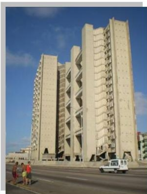
Fotos 23 y 24 Edificio Experimental de Malecón y F (1965) con empleo de hormigones de altas prestaciones, mayor de 55,0 MPa, colocados con bomba en 2002 en el Edificio Atlantic, ambos en el Vedado.
