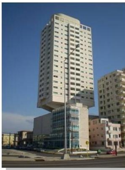
Fotos 23 y 24 Edificio Experimental de Malecón y F (1965) con empleo de hormigones de altas prestaciones, mayor de 55,0 MPa, colocados con bomba en 2002 en el Edificio Atlantic, ambos en el Vedado.
