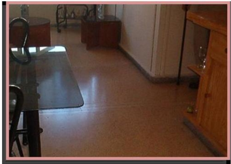
Foto 19. Piso de terrazo integral colocado directamente, y al mismo tiempo, sobre la losa de entrepiso en la planta, que luego se colocan en la obra simultáneamente, en edificio construido en 1973 en el Reparto Guiteras
