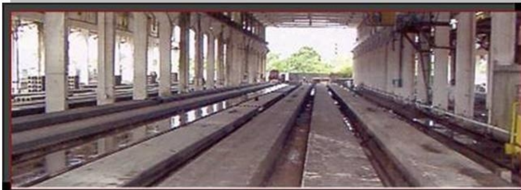
Foto 21. Planta de Losas Huecas Spiroll de la Unión de Construcciones Militares en San Cristóbal
